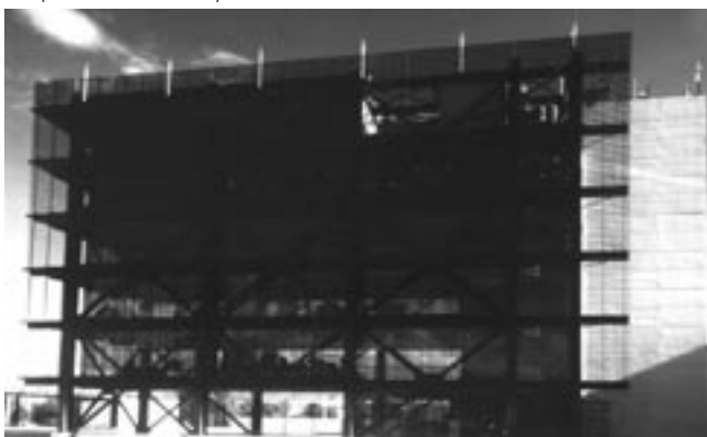
Edificio del IFE, Proyecto de Vinculación
