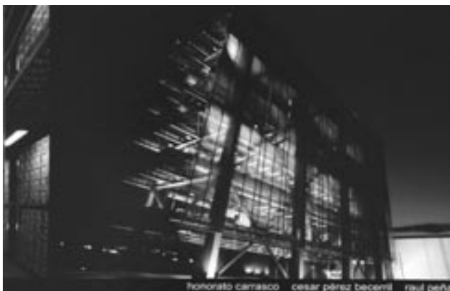
Edificio del IFE, Proyecto de Vinculación
